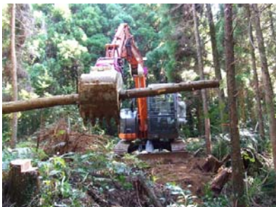
【グラップル付バケットによる路網開設】
