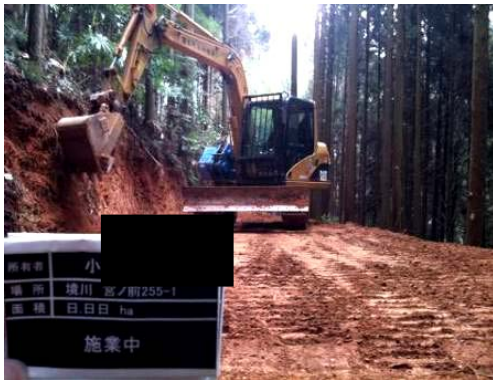
【バックホウによる作業道開設状況】
