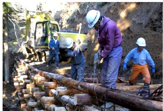
【急傾斜地（傾斜 45°）での丸太積工の施工】
