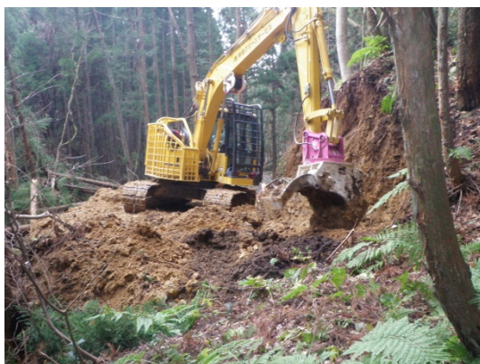
【森林作業道開設状況】
