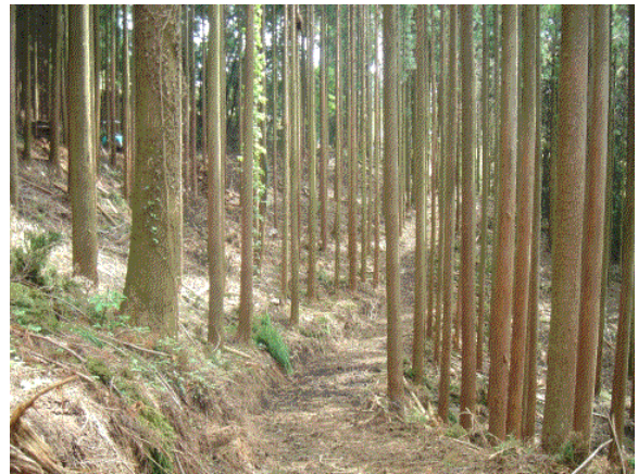
環境に配慮した作業路開設
