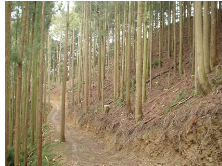
作業路開設状況
