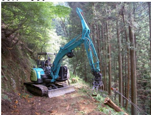
スイングヤーダによる集材作業
