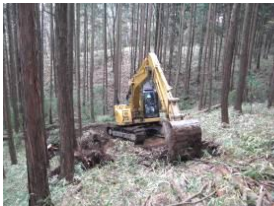
簡易作業路開設
