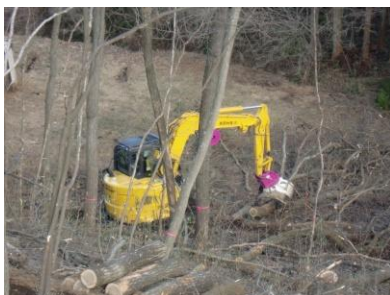
ザウルスによる作業路作設状況
