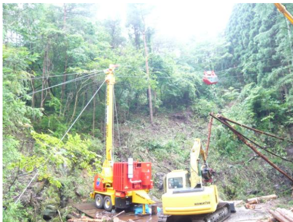
オートパワーマストでの集材作業
