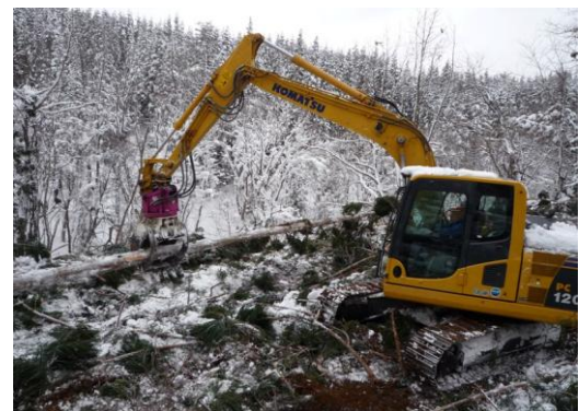
ザウルスロボによる作業路開設
