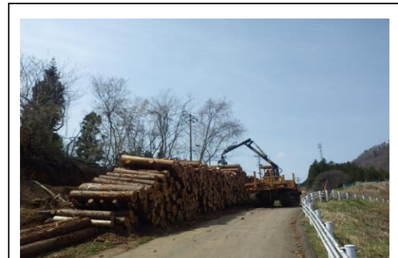
【フォワーダによる荷降ろし・はい積み】
