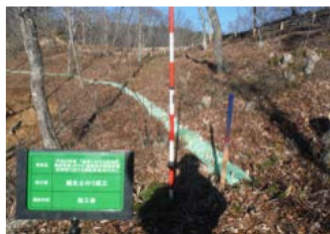
植生土のう筋工
