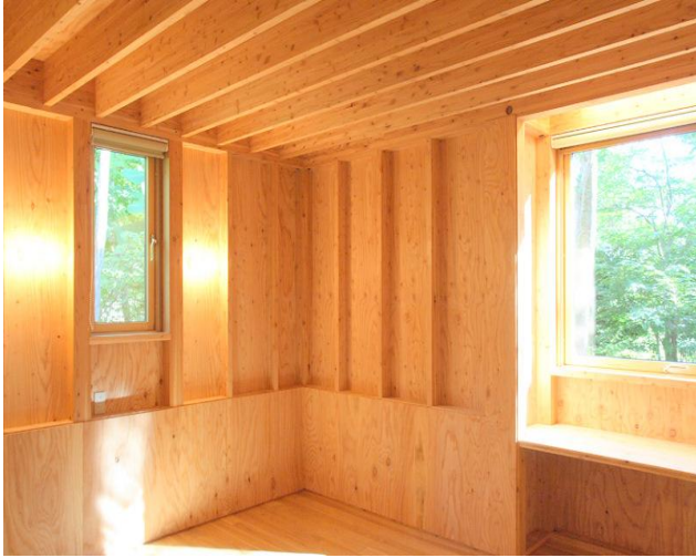
住宅建設(床・壁・屋根)
