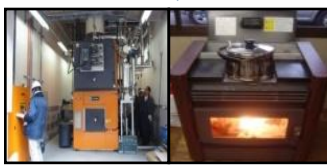
木くず焚きボイラー ペレットストーブ 石炭混焼 等
