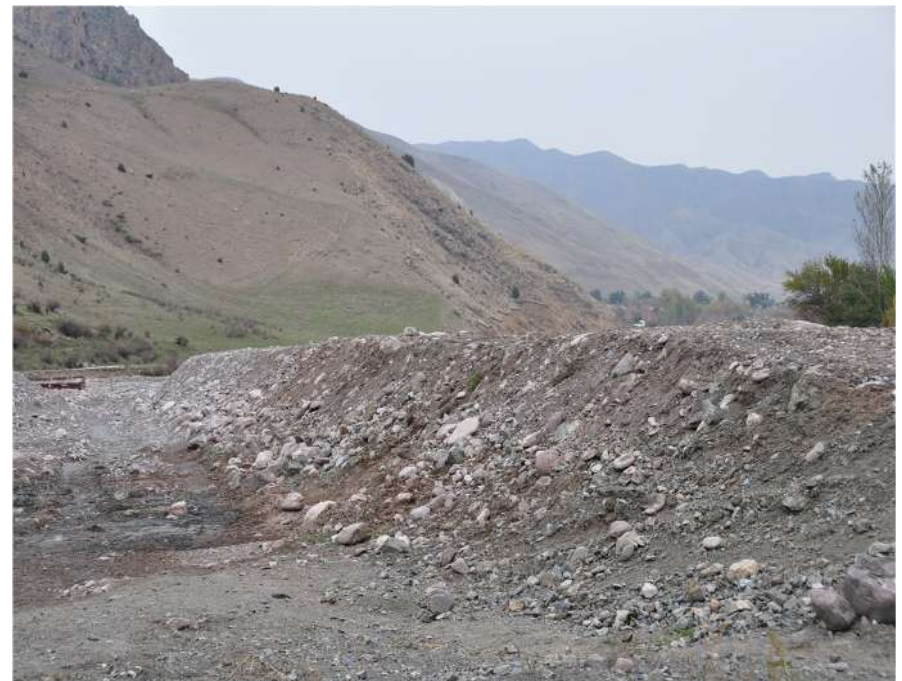
地元企業の協力で建設した導水堤 (ケゲティ)
