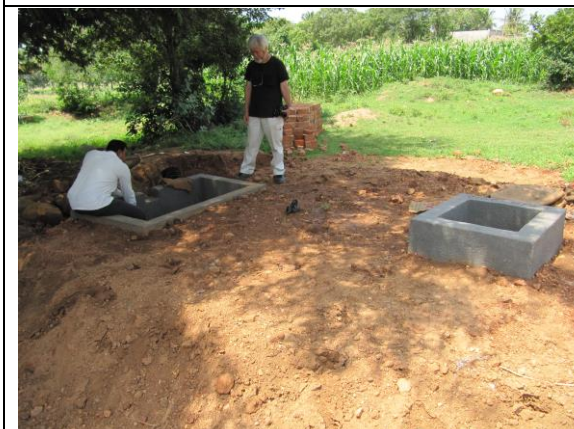
写真 3：新しいバイオガスユニットの建設
