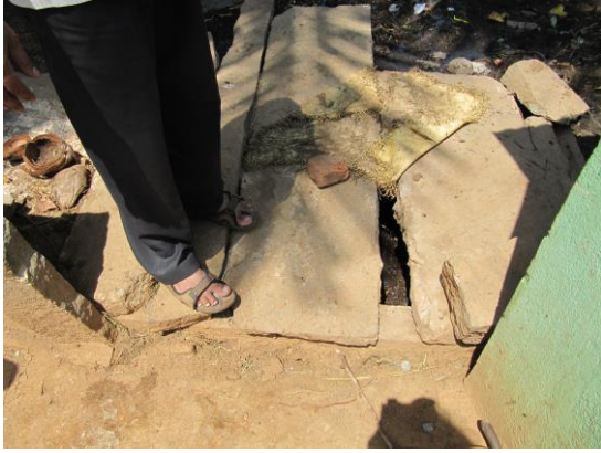
写真 7 : 糞の貯留場所 (ここでメタンガスを発酵する。)
