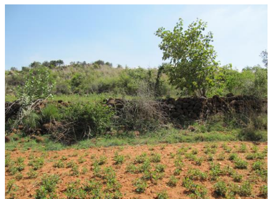
写真 18：積み上げられた石によって土砂が流出するのを防ぎ、安定化させる。
