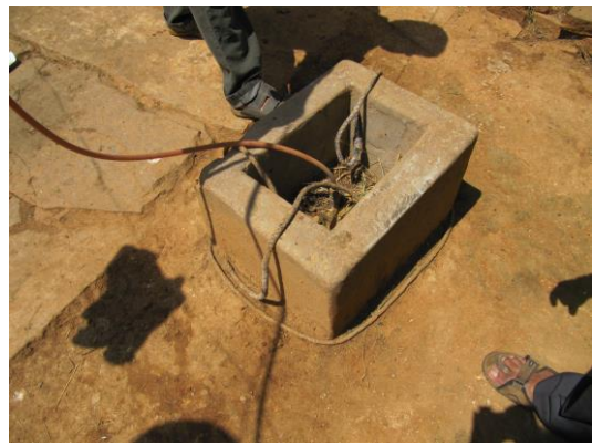
Photo 8 : 農家へメタンガスを送る配線と切り替えスイッチ
