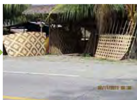
葉軸を編込んで壁面化
