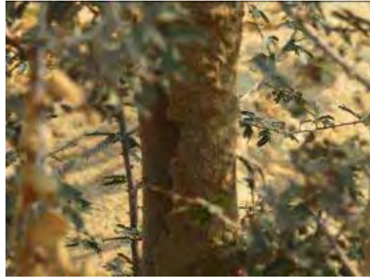
写真 B-91. Jand の天然木の一部でシロアリの被害が出ていた。
