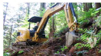
急傾斜地に小型機械で支線を作設
