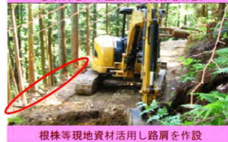
急傾斜地に小型機械で支線を作設
