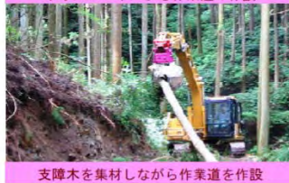
ザウルスロボによる作業道の作設
