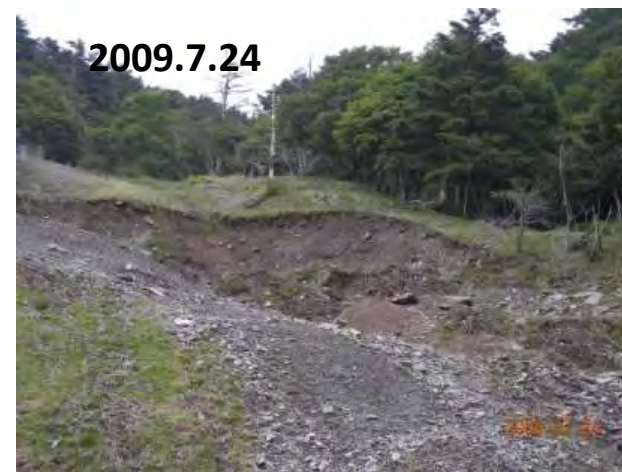
土砂の崩壊も発生→ 森林の有する国土保全機能の低下
