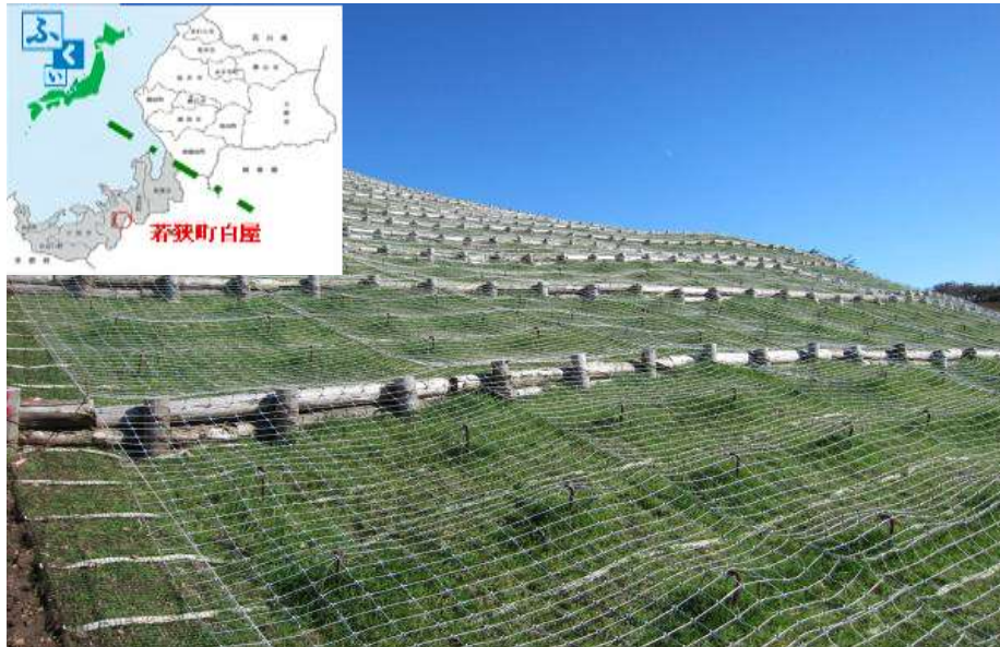
一部完了状況(2014.10)
