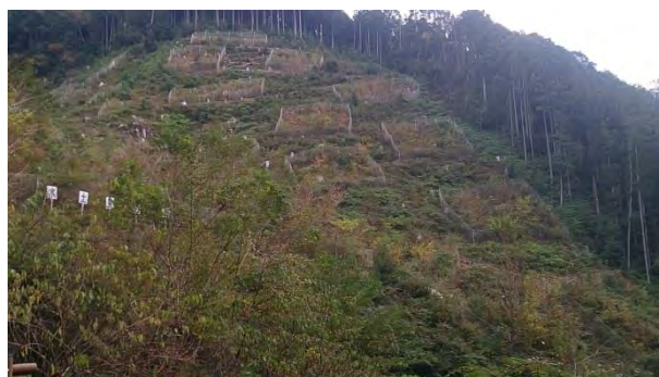
写真 2-1-2 大台町に行けるパッチディフェンスの施工例（民有林）
