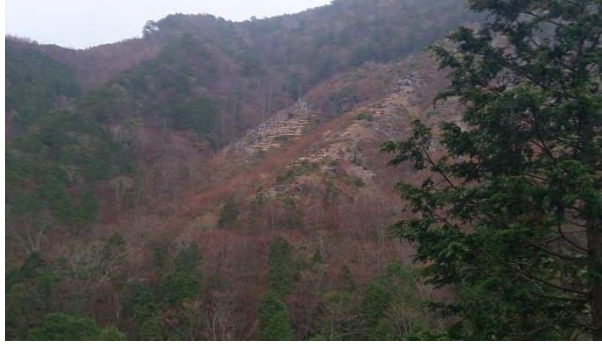
写真 2-1-3 堂倉沢左岸山腹荒廃地における山腹工事の状況 丸太柵工による土砂止めと広葉樹の植栽を行い、周囲を植生保護柵で囲っている。
