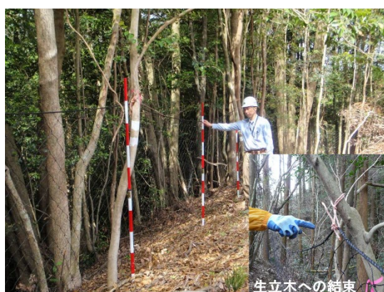
写真3 生立木を支柱としてネットを固定する防護柵の設置状況
