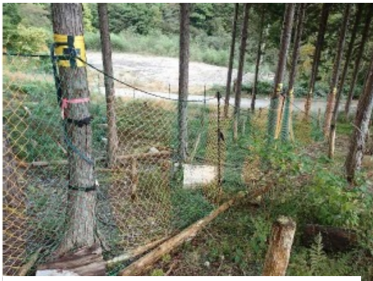
写真1 立木を支柱に利用した防護柵
