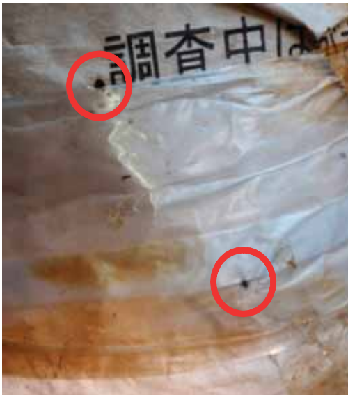
写真-4 シートを突き破った跡
