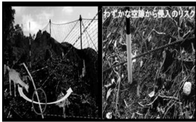
写真6：下辺部の空隙
