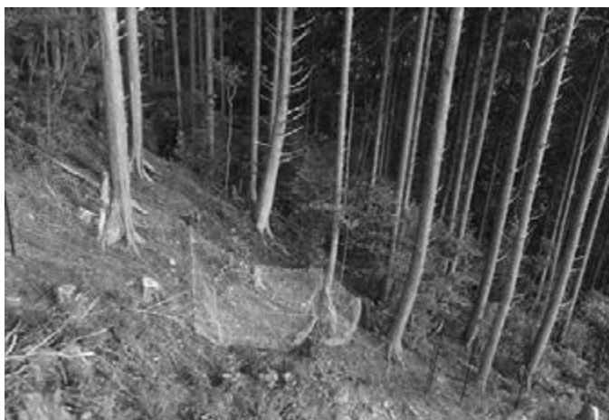
写真9：ドローンの巡視状況
