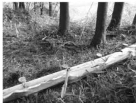
(写真-4) 丸太筋工背面のポケット
