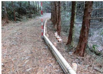
(写真-3) 作業道路肩に設置した木柵及び土砂受け箱
