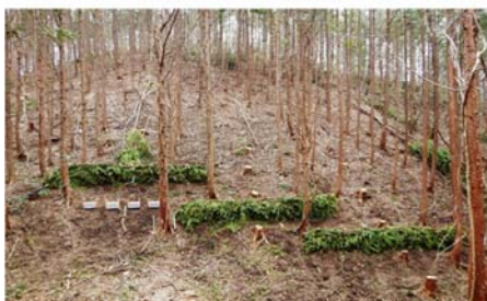
(写真-4) 左上：チップ散布状況 左下：枝葉編柵設置状況、右上下：枝葉散布状況
