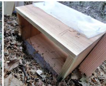
(写真-3) 作業道路肩に設置した木柵及び土砂受け箱
