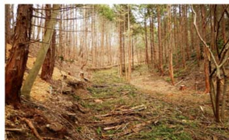
(写真-4) 左上：チップ散布状況 左下：枝葉編柵設置状況、右上下：枝葉散布状況
