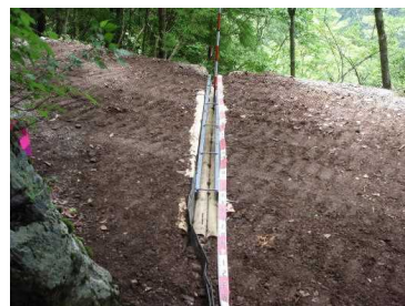
写真-1 Ver. 1 設置直後の様子
