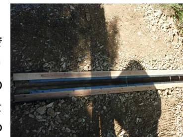
写真-2 Ver. 2 設置直後の様子
