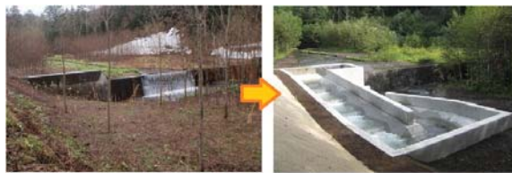
図 1 オニセツ沢川 10 号床固工の改良前（左）と改良後（右）
