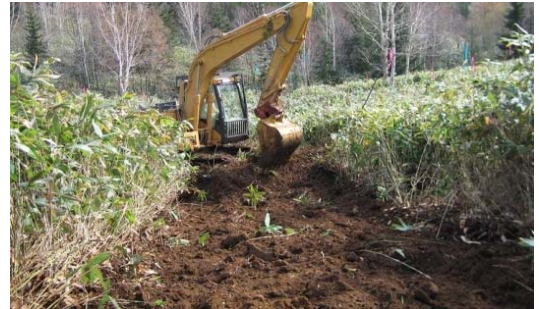
(写真)バックホウによる地拵
