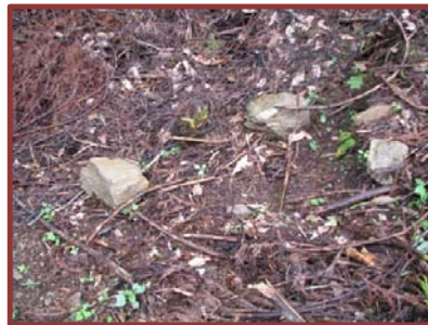
（写真5）石による補修
