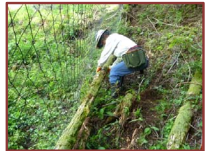
（写真6）丸太による補修
