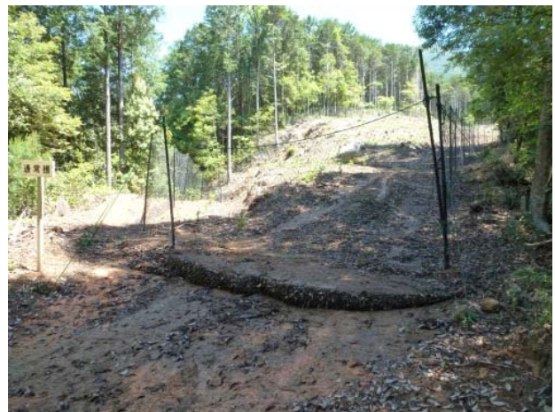
（写真2）枝条・土砂の堆積状況
