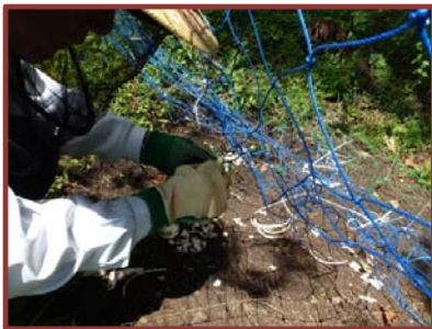
（写真4）結束バンドによる補修
