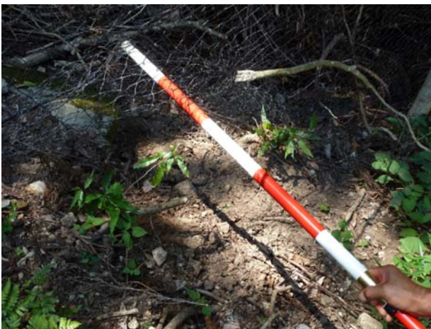
（写真1）ネットへの侵入口
