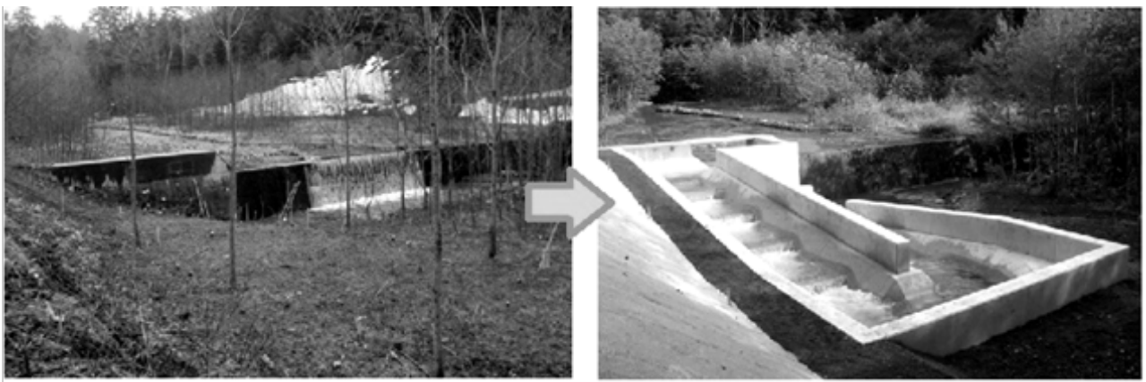
図 3. オニセツ沢川 10 号床固工の改良前（左）と改良後（右）
