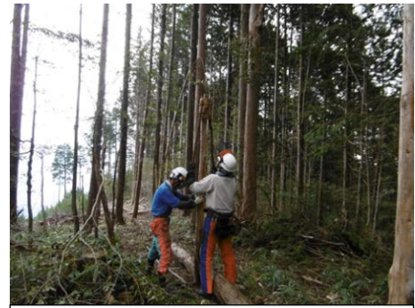
写真7 丸太支柱杭の打設
