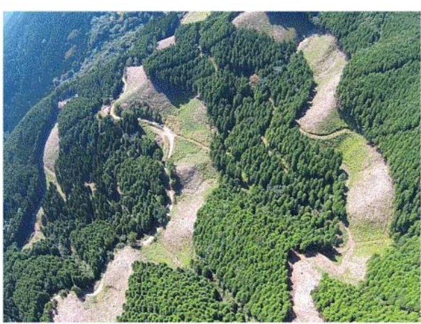
写真－5 実施後の状況（上空）
