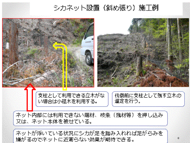
写真－3 立木利用の斜め張り施工例
