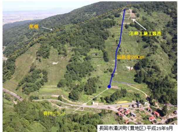
写真－8 高揚程箇所における法枠工の施工状況
