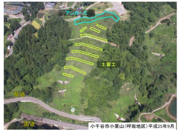
写真-12 復旧状況
