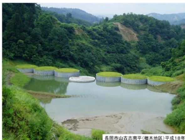
写真－17 鋼製セルダムの完成状況
