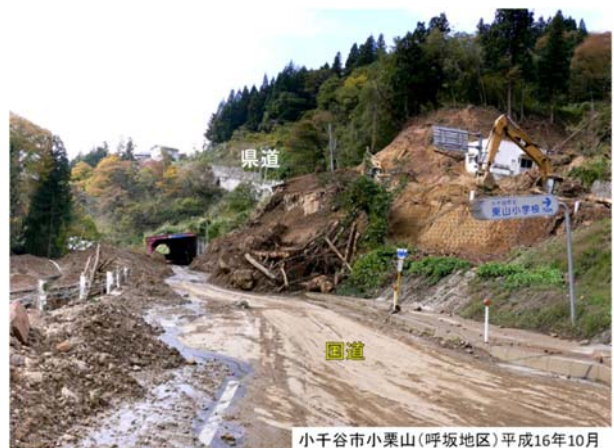
写真－10 国道・県道の被災状況
