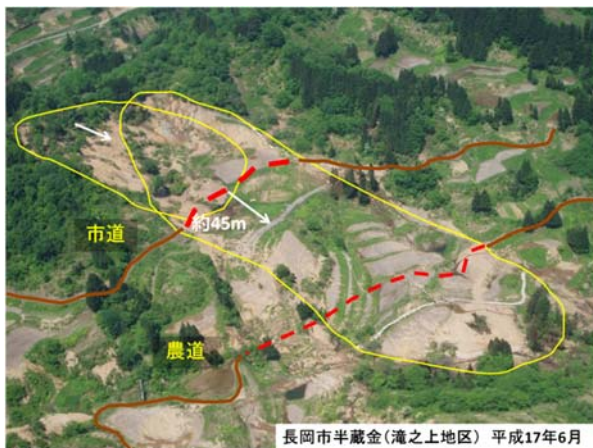
写真－1 第三紀層地すべりによる被災状況
