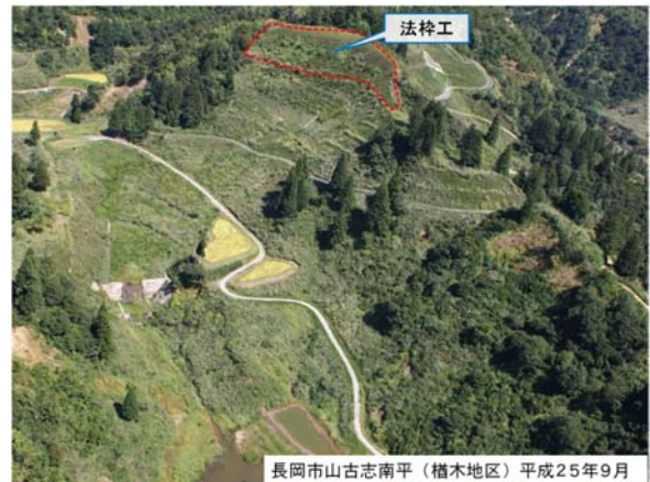
写真－6 復旧状況
