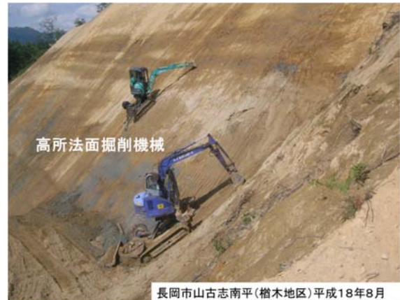
写真－4 機械による法切工の施工状況
