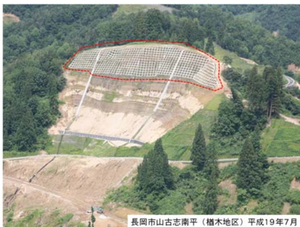
写真－5 法枠工施工後
