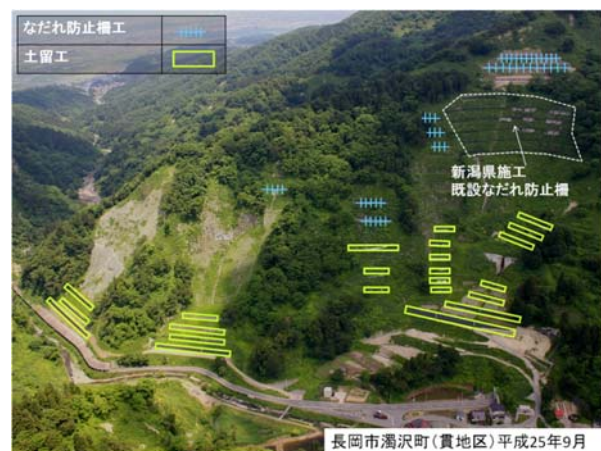
写真-15 復旧状況
