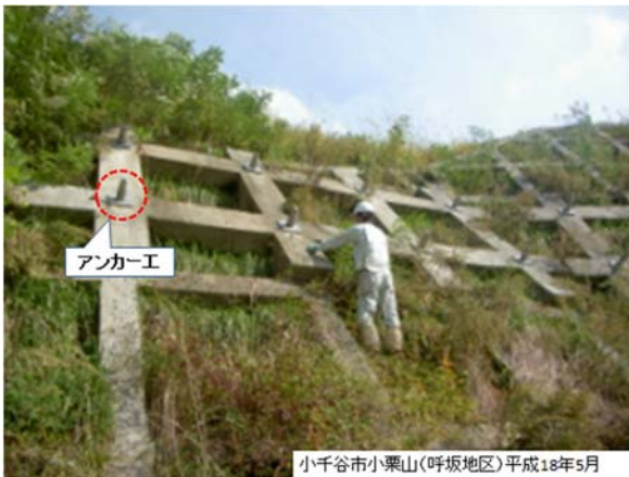
写真-11 アンカー工の施工状況
