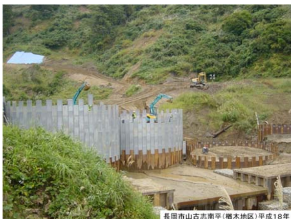
写真－16 鋼製セルダムの施工状況
