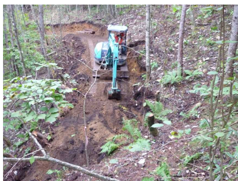
試験地での作業道作設
