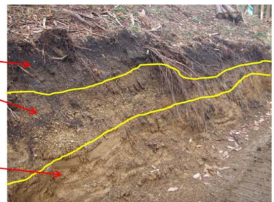
写真-8 森林作業道作設中の土質
