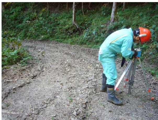
写真-3 キャスポルによる計測の様子
