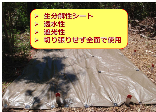
写真5 防草シート設置
