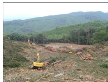
林道周辺の全木集材等の状況
