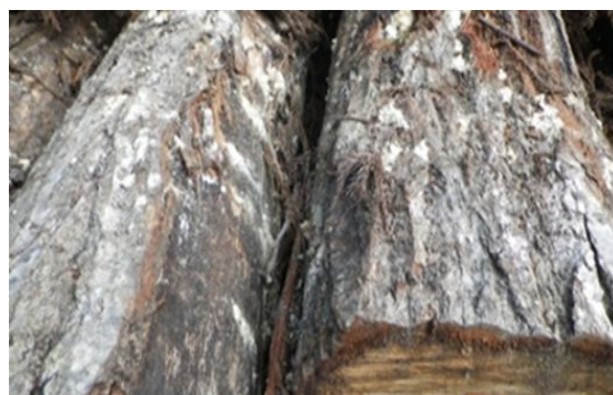
(写真7 上部の丸太 穿入状況)
