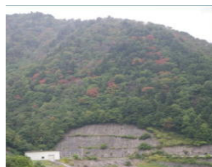
(写真1 喜多方市被害箇所)
