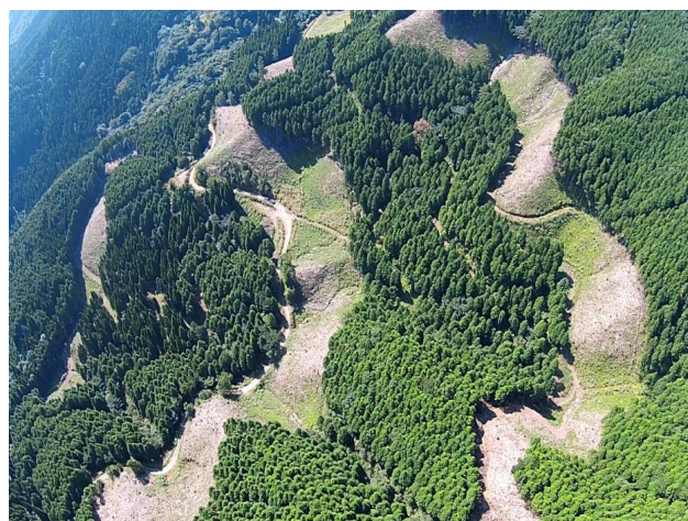
写真 11 マルチコプターからの写真 （誘導伐実施後の状況）
