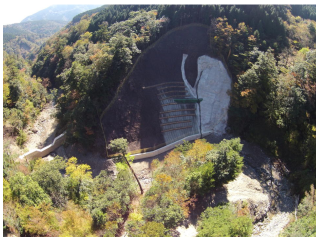
写真 10 マルチコプターからの写真 （治山事業実施後の状況）
