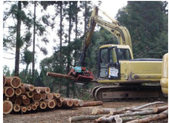
写真－２ 林外での枝払い・造材作業
