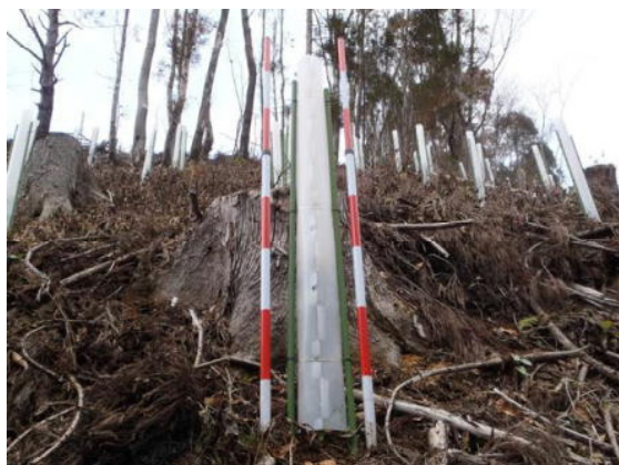
写真－9 支柱を左右にした従来型シェルター
