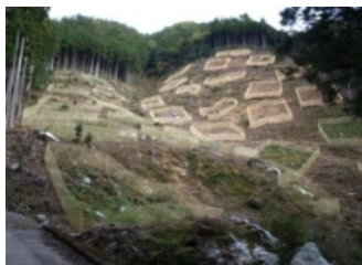
防護柵の設置
