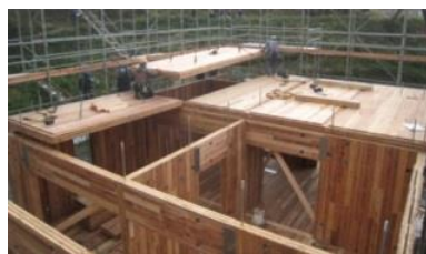
施工性のデータ収集等を目的としたCLT建築物の実証
