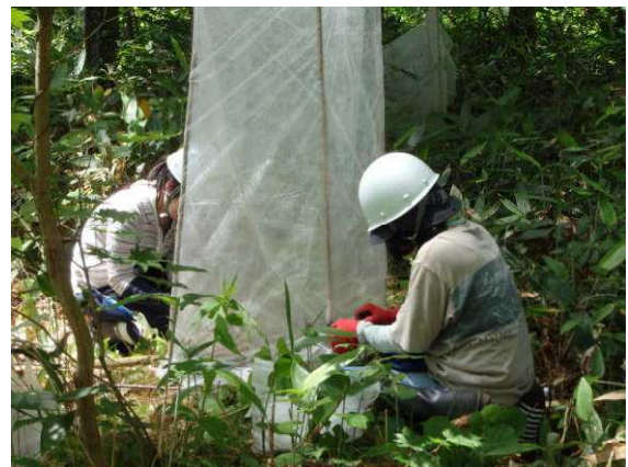
(シートの修繕)
