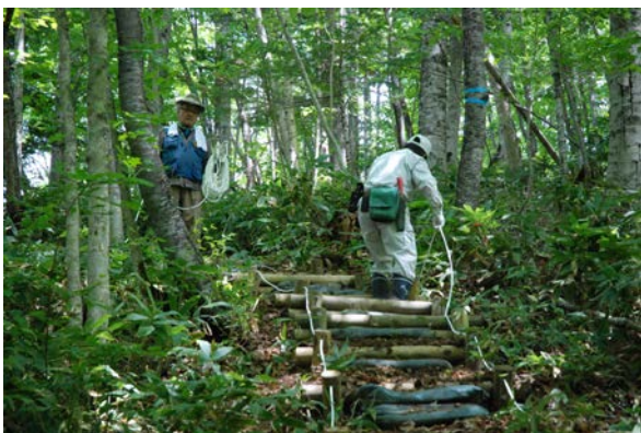
（散策路階段の補修）
