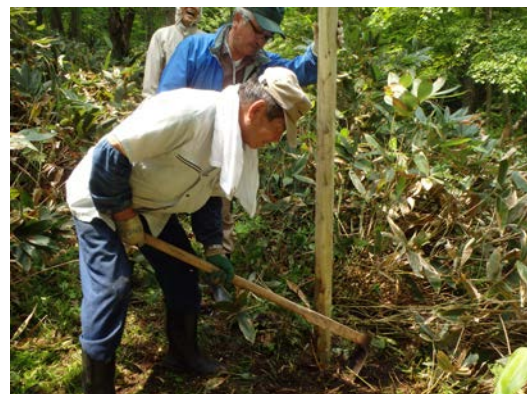
（看板を付ける支柱を埋めています）
