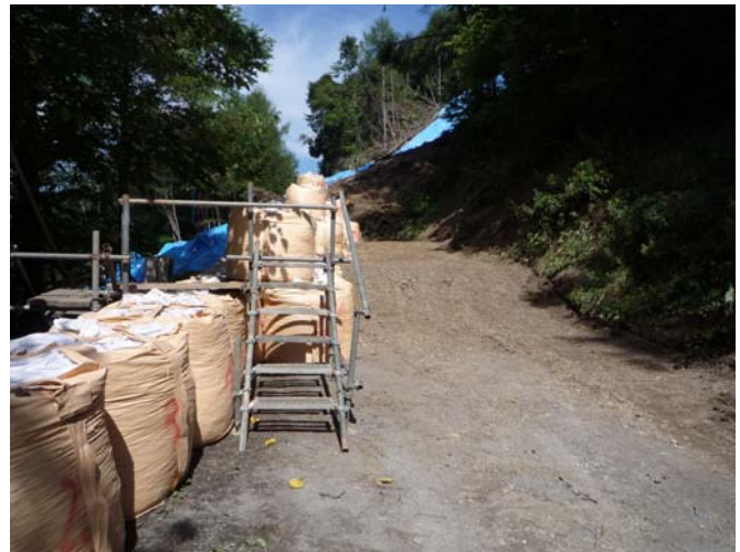
図 20 大型土嚢による泥流捕捉・導流施設設置状況
