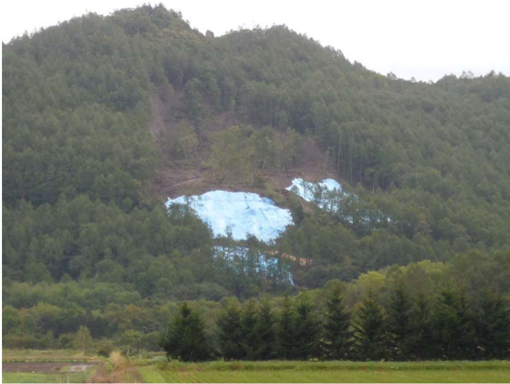
図 29 応急対策施工中の全景
