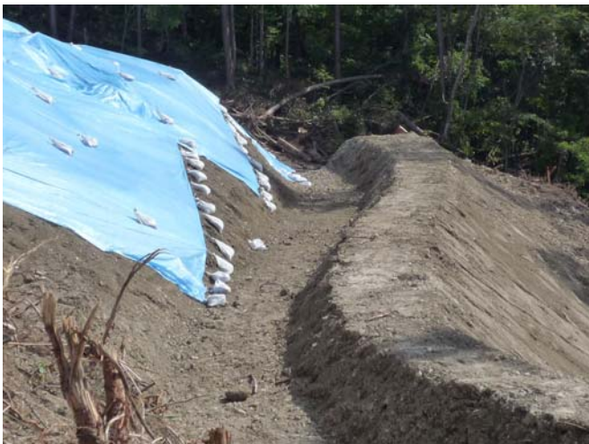
図 22 シートによる被覆と素堀水路
