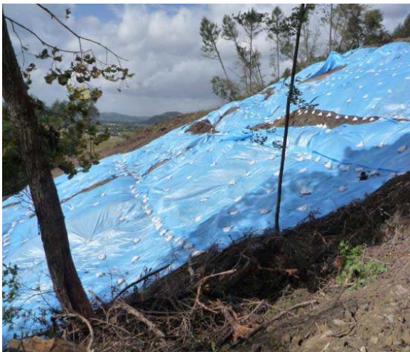
図 24 シートによる斜面の被覆
