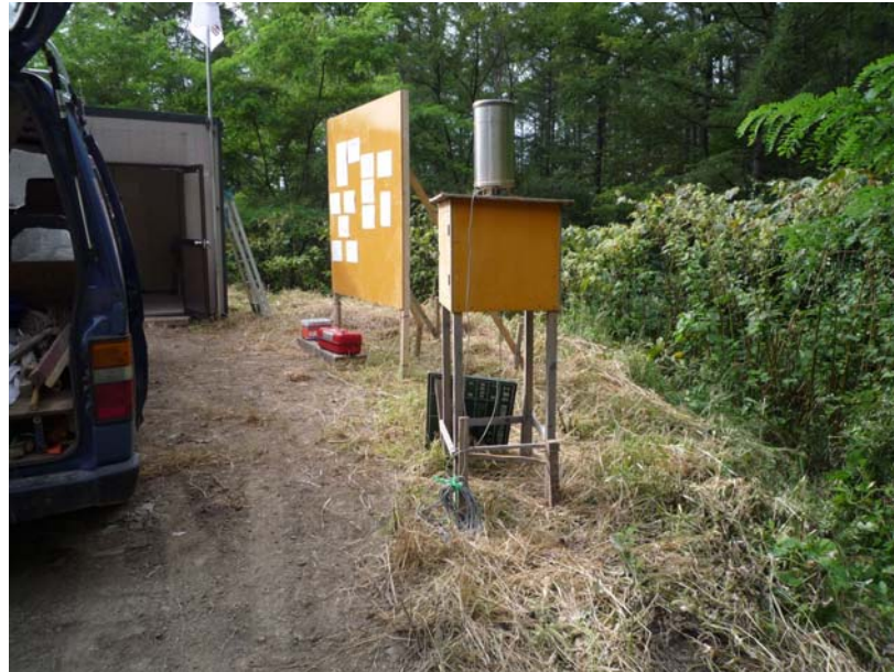
図 30 雨量計設置状況
