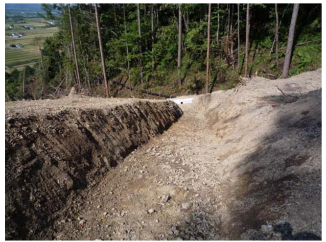
図 23 素堀水路と地すべり地外への排水管
