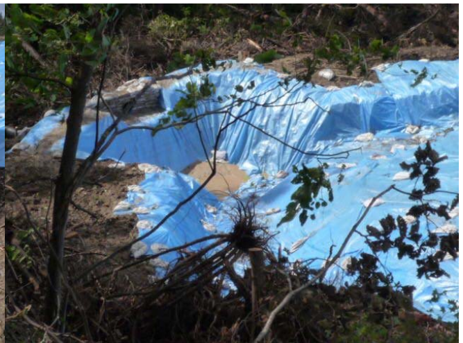
図 25 泥だめと地すべり地外への排水管
