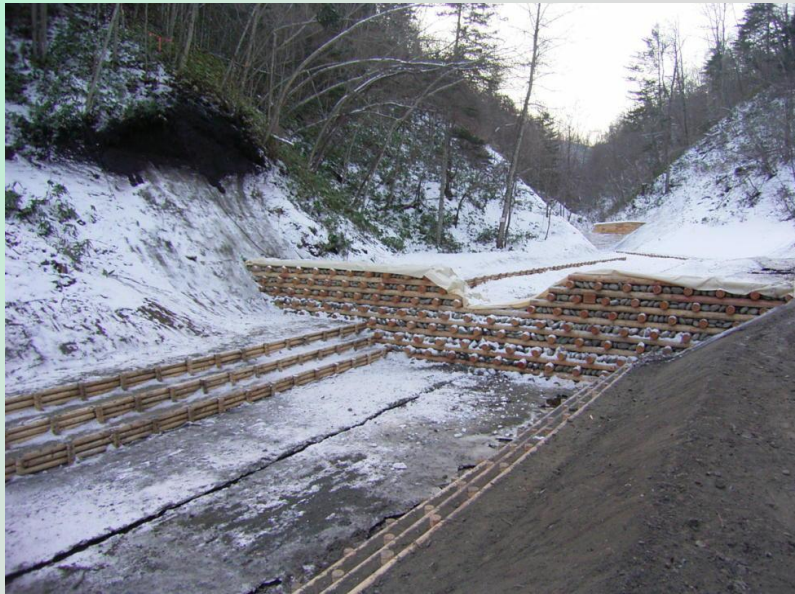
【 残置式型枠使用コンクリートダム(下流側より) 】
