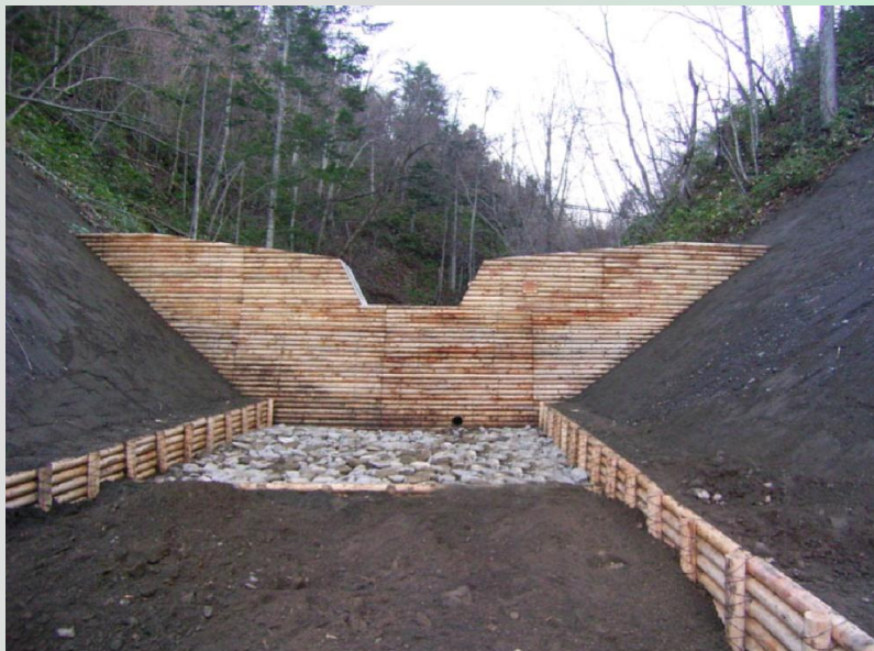
【 残置式型枠使用コンクリートダム(下流側より) 】
